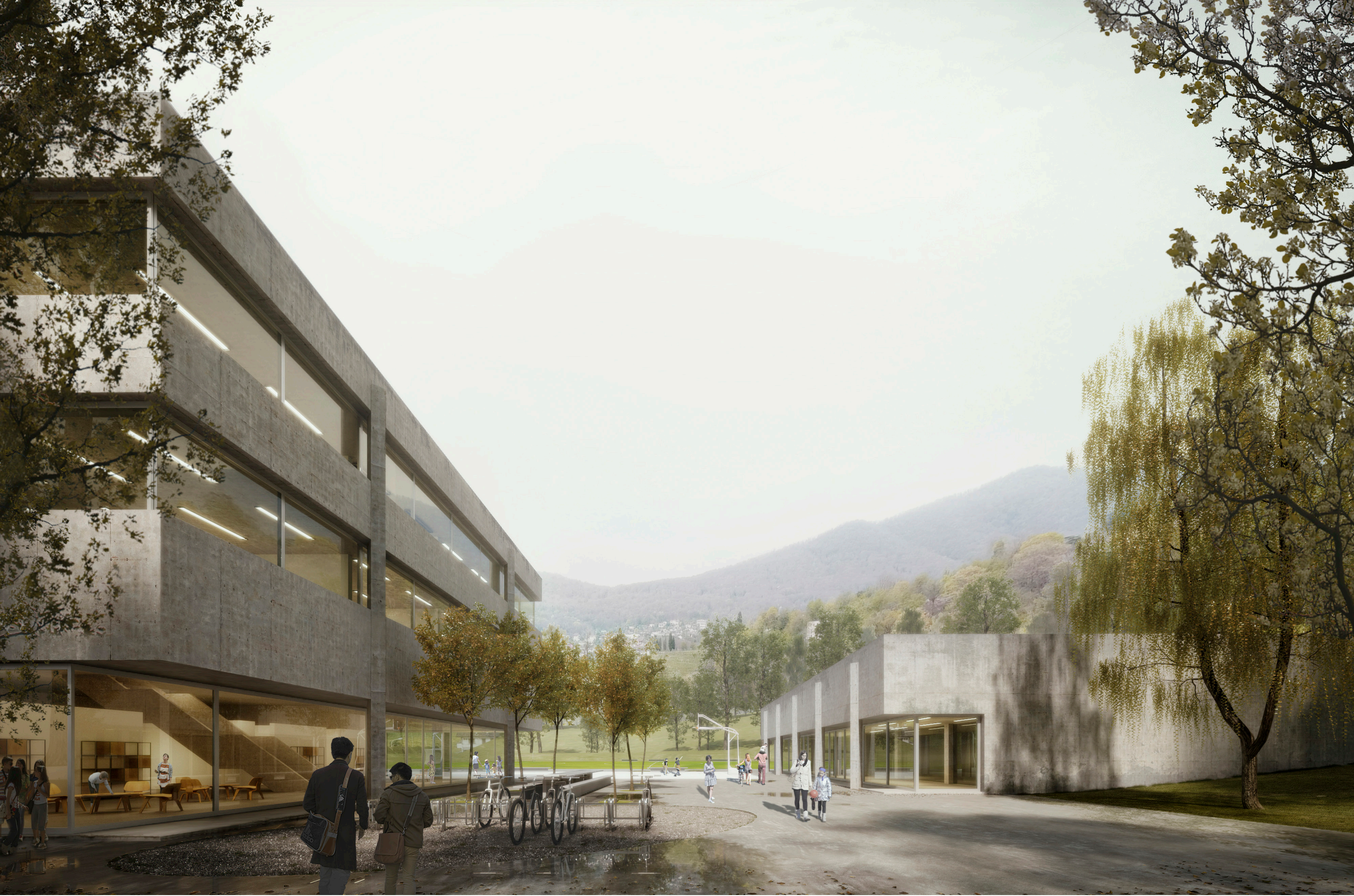
Vista esterna della scuola elementare e della palestra
